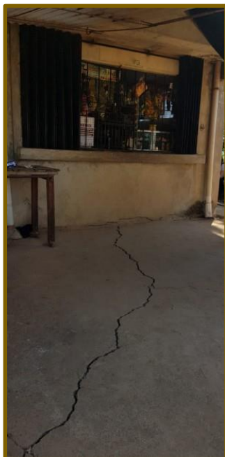
Figuur 5: Een onstabiele ondergrond, nog een gevolg van de grootschalige mijnbouw in de regio.
